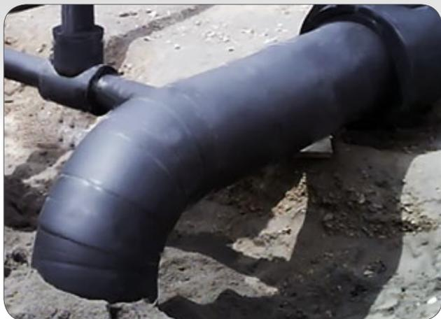
Техническая теплоизоляция «K-FLEX» марки IGO предназначена для тепловой изоляции трубопроводов с положительными и отрицательными температурами и фасонных изделий к ним, прокладываемых подземным и надземным способом, а также для теплоизоляции сварных стыков трубопроводов, запорной и регулирующей арматуры, фильтров-грязеуловителей и других элементов трубопроводов в качестве теплоизоляционного слоя в конструкции тепловой изоляции.
